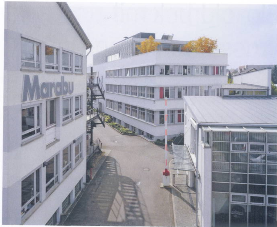
Die Farbenfabrik von Marabu in Tamm
